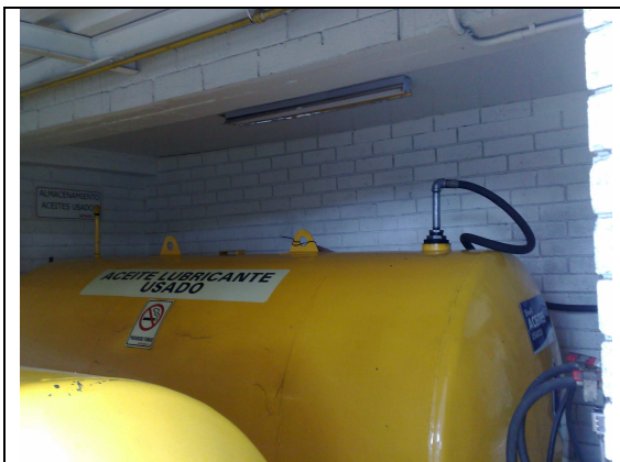
FOTO No. 3 DEPÓSITO DE ACEITE USADO
