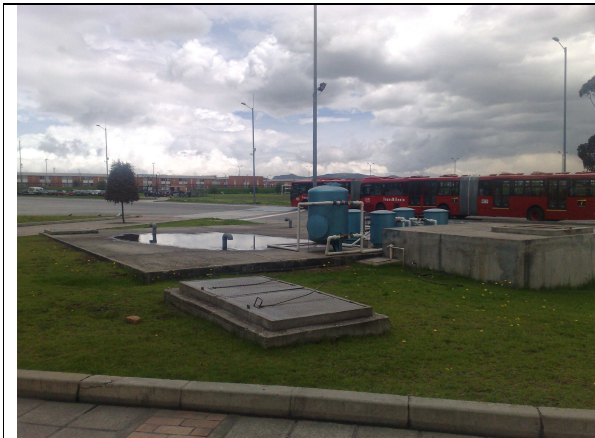
FOTO No. 8 PLANTA DE TRATAMIENTO DE AGUAS RESIDUALES
