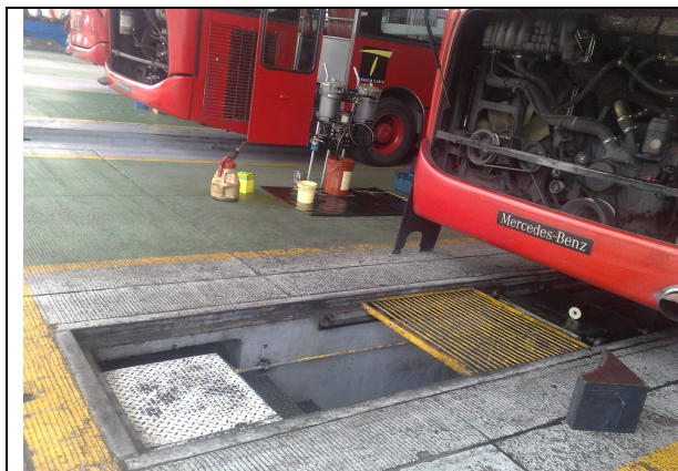
FOTO No. 10 CÁRCAMO DE SUMINISTRO DE ACEITE NUEVO
