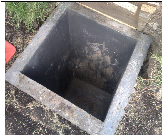
FOTO No. 5 POZO DE INSPECCIÓN
