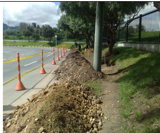
FOTO No. 6 CUBRIMIENTO DE LOS DUCTOS INSTALADOS
