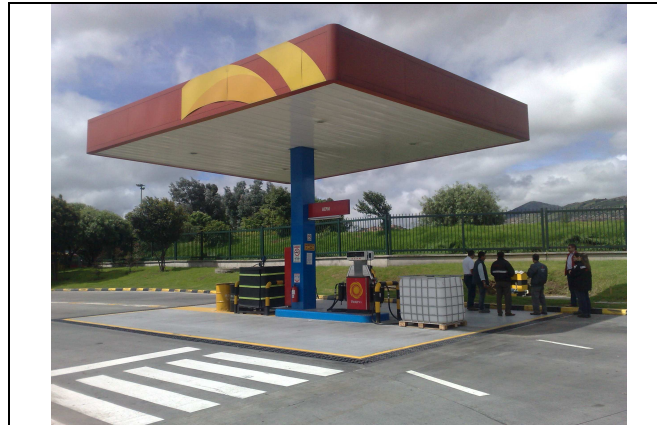
FOTO No. 7 ESTACIÓN DE SUMINISTRO DE COMBUSTIBLE.
